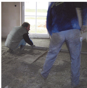
Obr.3 Potěr rovnoměrně rozdělít, ztuhnit a vyrovnat stahovací laťí.
