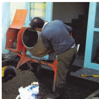
Obr.2 Potěr namíchat vhodnou míchačkou.
