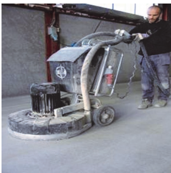
Obr.1 Podklad připravit předepsaným způsobem.
