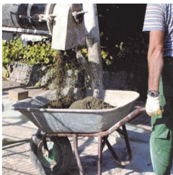
Obr.1a Namíchání malty pomocí kontinuální míchačky ze sila.
