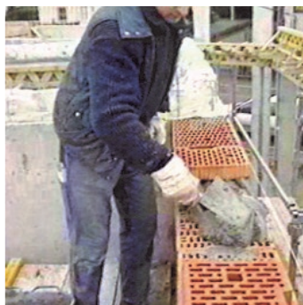
Obr.2 Nanášení zdicí malty na zdivo.
