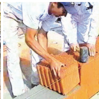
Obr.3 Pokládání cihelných bloků.
