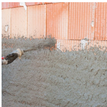
Obr.1 Nástřík omítky pomocí omítačky.
