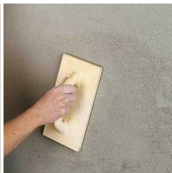
Obr.3 Urovnání povrchu hladítkem.
