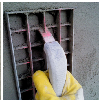
Obr.4 Následující den strhnout povrch škrabákem.
