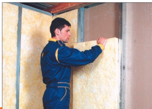
Ukázka aplikace výrobku Isover PIANO
