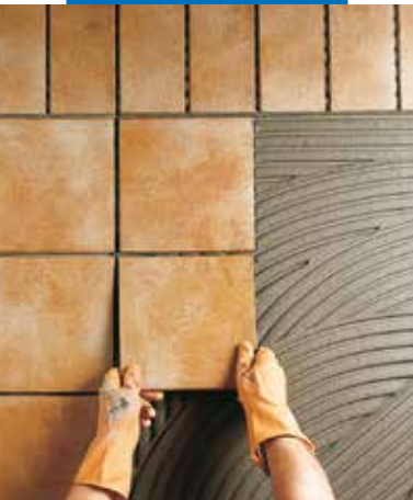
Lepení klinkeru v exteriéru
