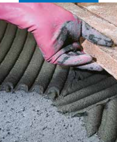
Lepení dlažby typu cotto na nevyrovnaný cementový potěr
