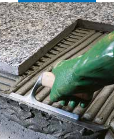
Lepení vymývané betonové dlažby v exteriéru
