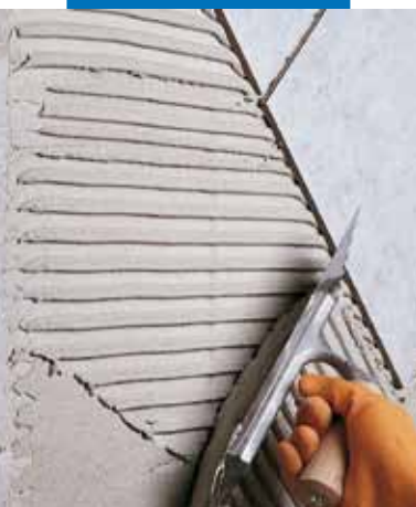
Lepení jednou pálených obkladů na stěnu z párobetonu
