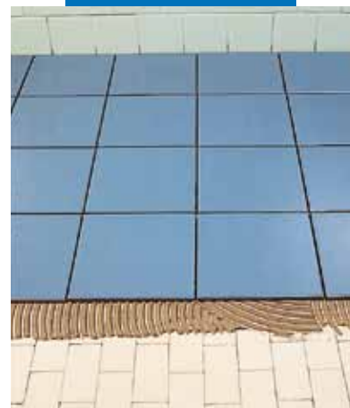
Lepení dlažby na stávající dlažbu šedým Keraflexem
