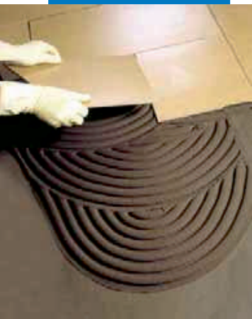
Pokládka keramické dlažby na potěr izolovaný Mapelastice
