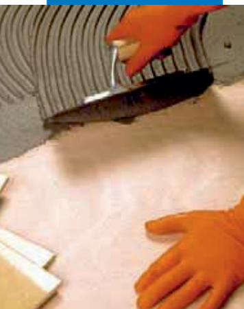
Pokládka keramické dlažby do Elastorapidu na podklad z lodní překličky
