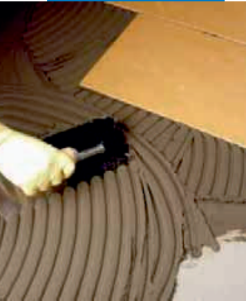
Nanášení Elastorapidu zubovou stěrku na cementový potěr
