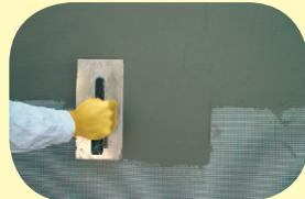
Pokud se vytváří základní vrstva, vkládá se skleněná síťovina do předem nanesené vrstvy stěrkové hmoty a vtláčí se dovnitř zahlažením nerezovým hladítkem směrem od středu ke krajům. Skleněná síťovina je v 1/3 tloušťky základní vrstvy od vrchu.
